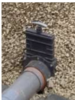
Illustration 22. Vanne de sectionnement inter-filtres.
