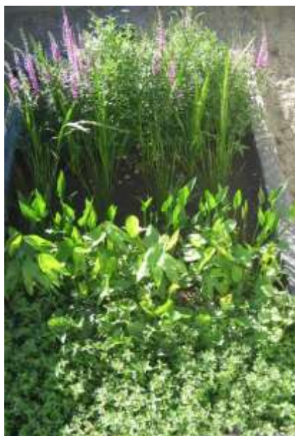
Illustration 16. Une prise de vue du filtre horizontal d'une Phytostation® 6 EH, huit semaines après l'installation.
